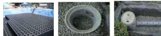
<雨水貯留浸透施設 (左から貯留施設、浸透ます、浸透トレンチ)>
