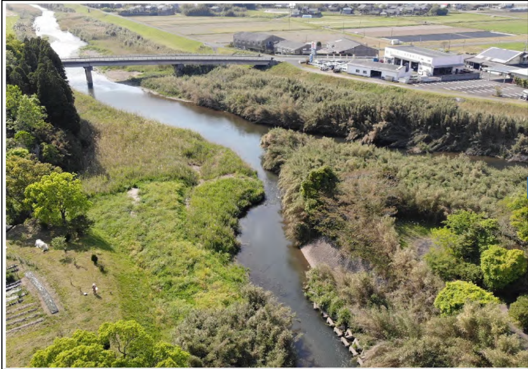
南九州市 麓川(着工前)
