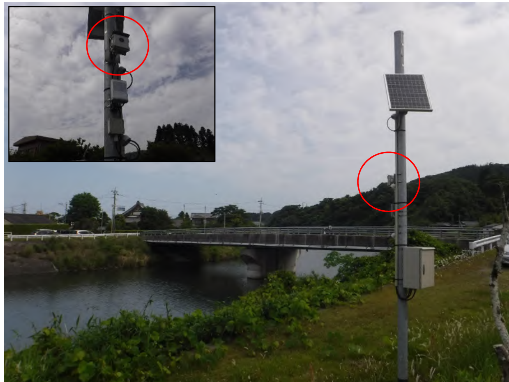
南さつま市 大浦川 磯間橋
