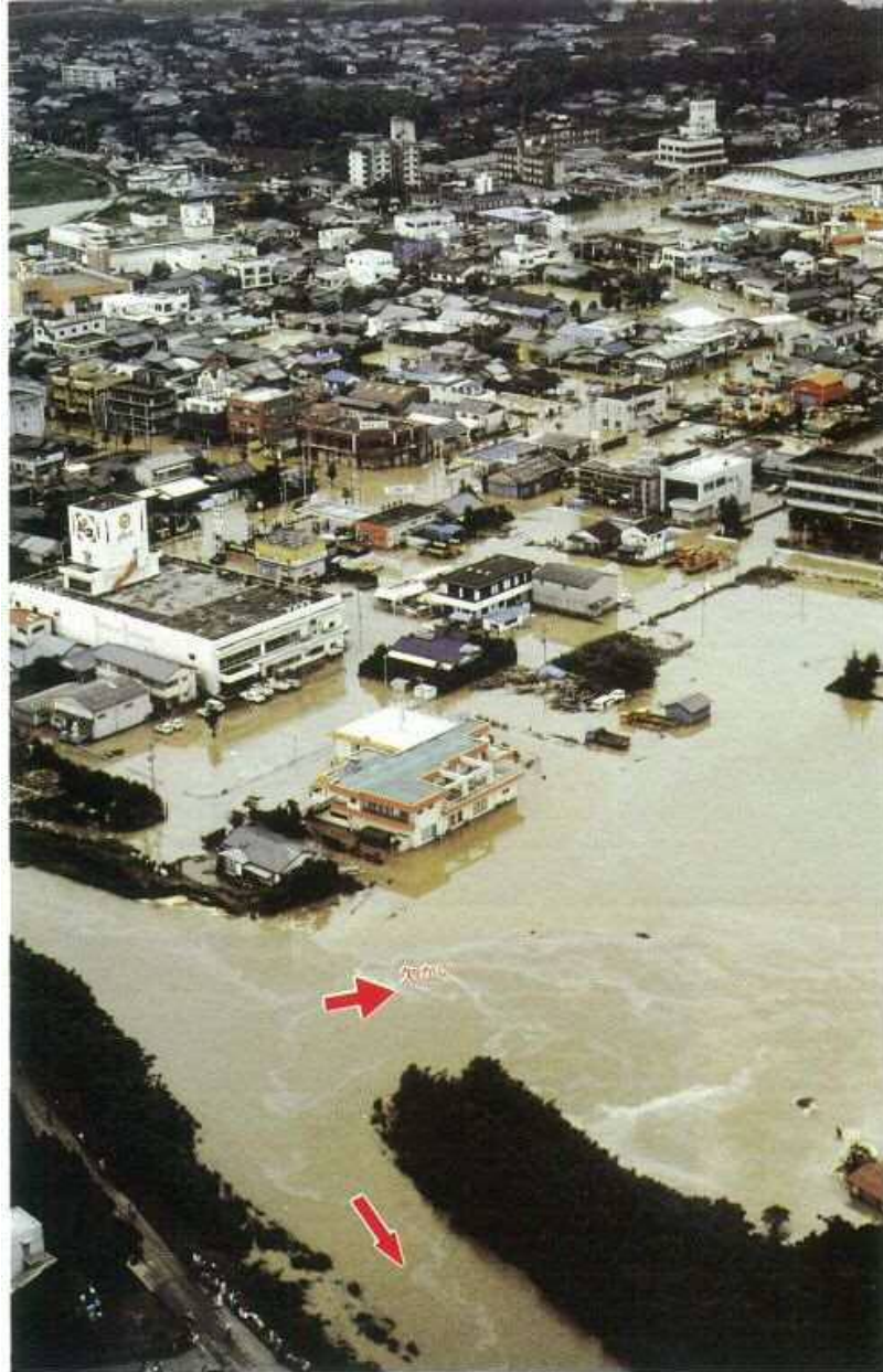
加世田川から氾濫する濁流（朝日新聞社提供） 昭和58年6月
