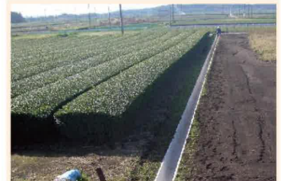
農地保全による承水路整備
