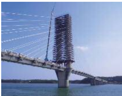
足場設置状況
