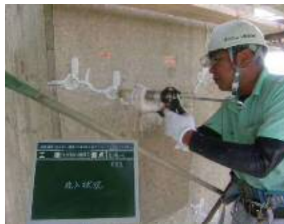
ひび割れ補修状況
