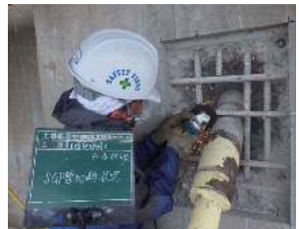
斜材カバー腐食箇所補修状況
