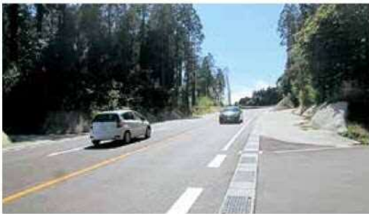
〔完成した池田工区(Ⅰ期)0.8km〕
