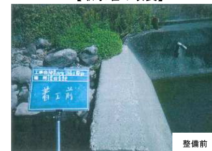
【取水堰の改良】
