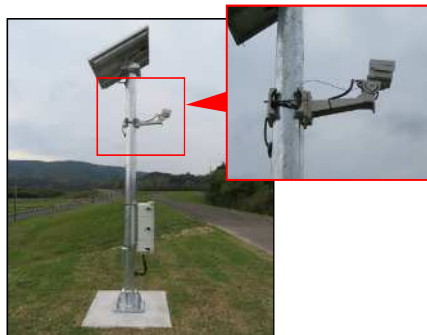
簡易型河川監視カメラ
