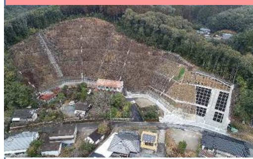
急傾斜地崩壊対策事業(日置市・樋掛下地区)
