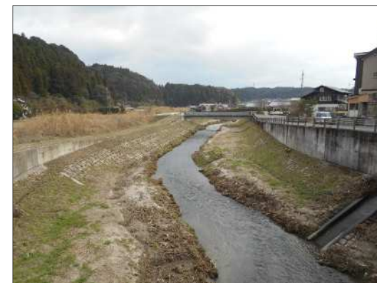
■整備状況(河川改修後)
