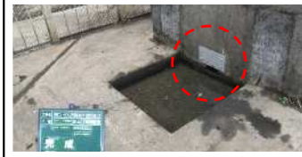
※ステンレス鋼板により径を縮小
