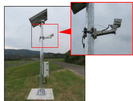
簡易型河川監視カメラ
