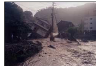
浸水被害(平成5年8月6日)
