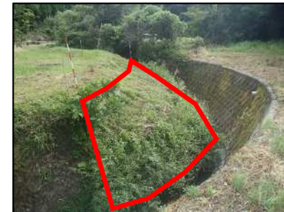
護岸整備を行い河道断面を確保する
