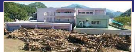
平成28年台風10号により、岩手県の要配慮者利用施設では利用者9名の全員が死亡。
