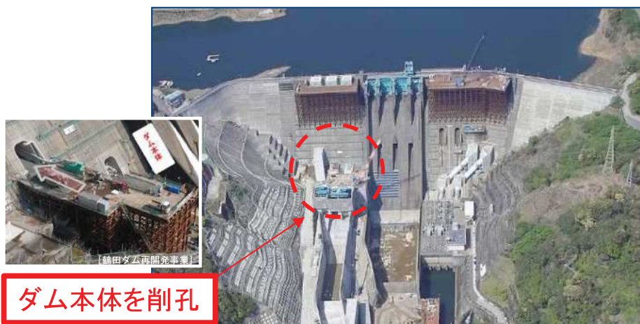
鶴田ダム再開発事業（鹿児島県薩摩郡さつま町）
