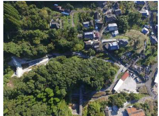
火山砂防事業 栗山追川(2) (いちき串木野市芹ヶ野地内)
