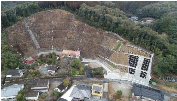
急傾斜地崩壊対策事業 樋掛下地区 (日置市伊集院町下神殿地内)
