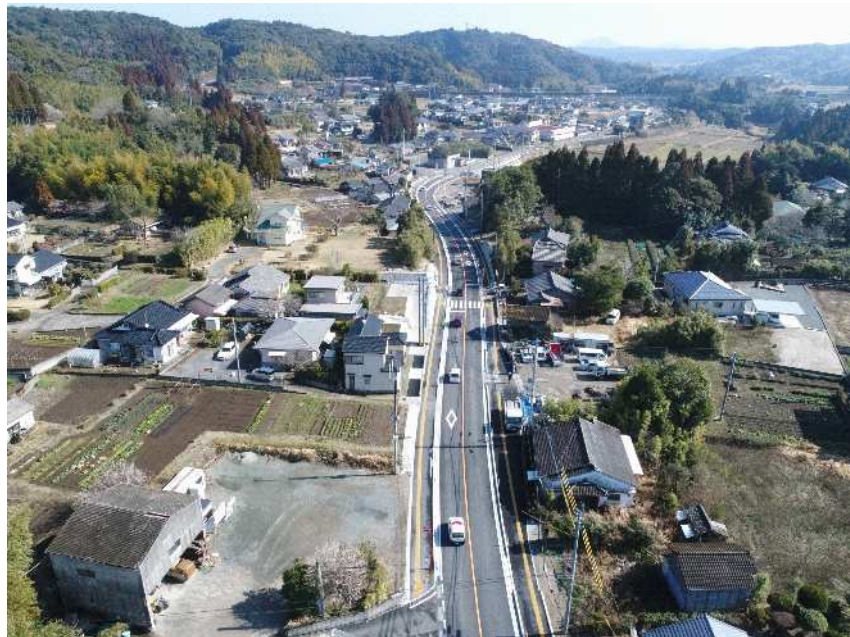
街路事業（郡中央通線）日置市伊集院町郡地内
