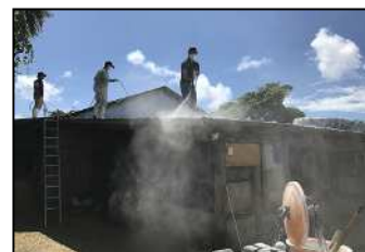
図2 屋根への石灰塗布
