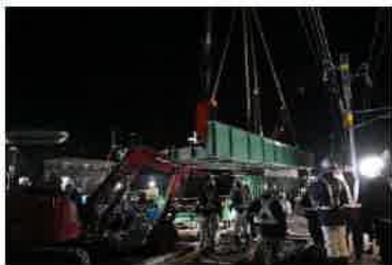
橋桁の架設状況
