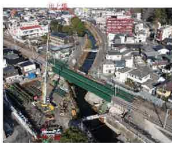
架設後の状況
