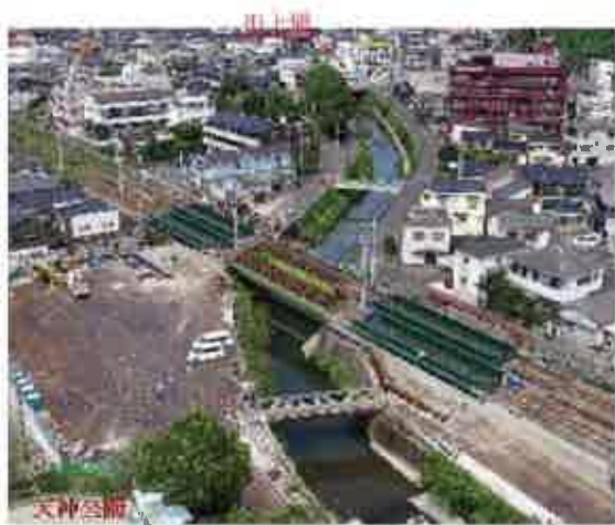
架設前の状況
