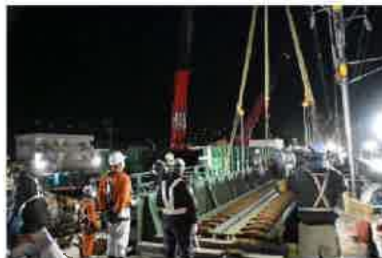
橋桁の架設完了状況
