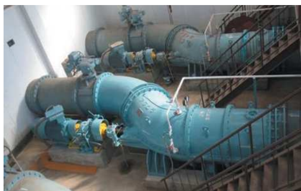
高江排水機場ポンプ改修 (薩摩川内市)
