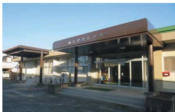
市来保健センター屋根防水改修 (いちき串木野市)
