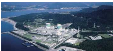
放水口、気象、排気筒4箇所、電気出力
