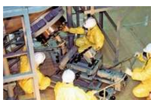
蒸気発生器水室部の開放、点検、復旧の訓練状況
