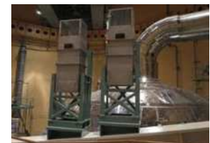
③静的触媒式水素再結合装置
