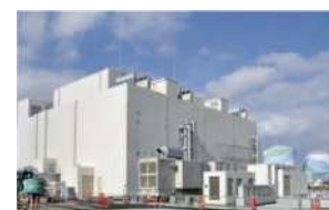
⑤緊急時対策所(指揮所)
