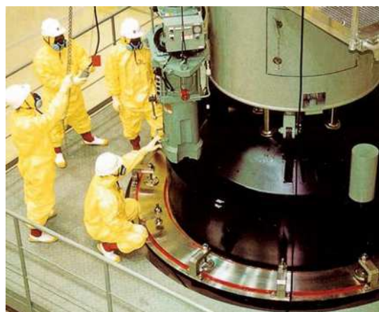
原子炉容器上蓋の開放、点検、復旧の訓練状況
