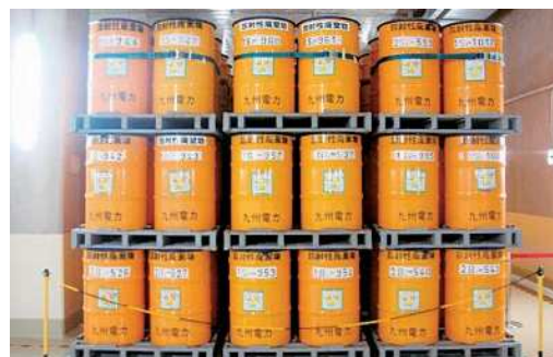
固体廃棄物貯蔵庫（内部）
