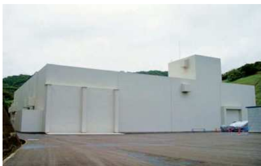
固体廃棄物貯蔵庫
