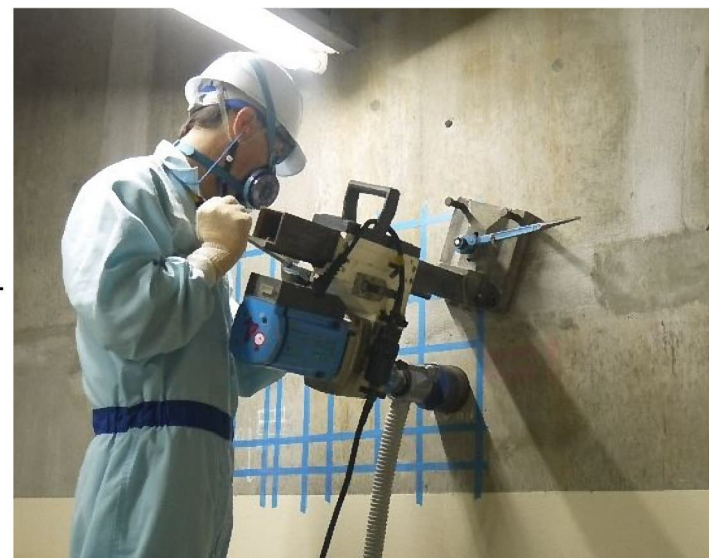
1号機コンクリートサンプル取得状況
