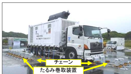
可搬型ディーゼル注入ポンプの固縛状況
