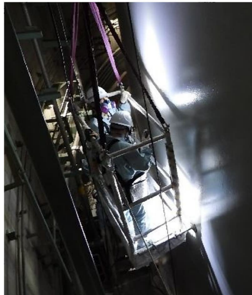
原子炉格納容器データ採取状況
