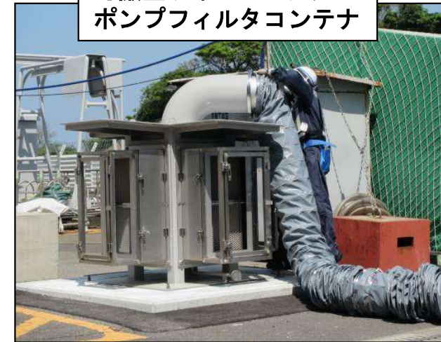
可搬型ディーゼル注入ポンプから 蒸気発生器2次側への注水（仮設ホース敷設）
