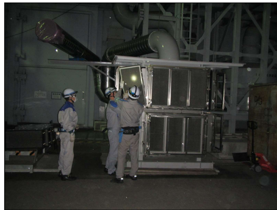
非常用ディーゼル発電機フィルタ コンテナのフィルタ取替
