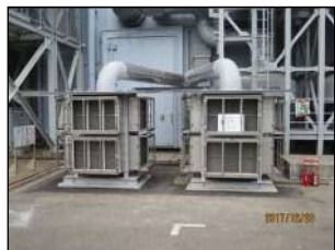
フィルタコンテナユニット(2基/DG)
