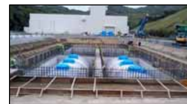
非常用ディーゼル発電機 燃料油貯蔵タンク増設
