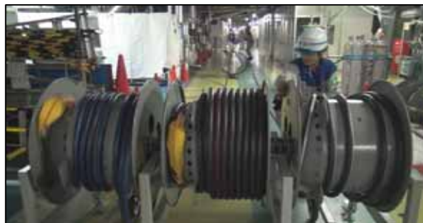
電源ケーブル敷設(屋内)
