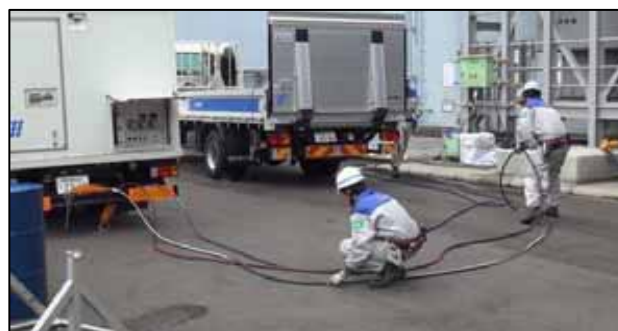
高圧発電機車へのケーブルつなぎ込み
