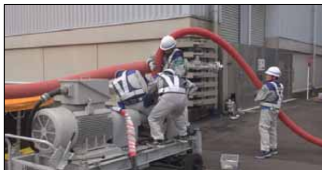
可搬型電動低圧注入ポンプの設置
