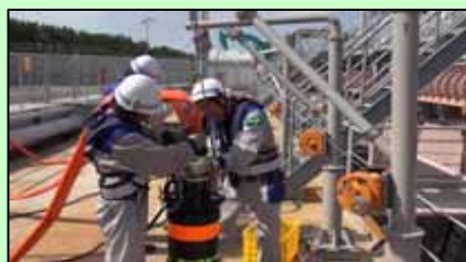
海水取水の水中ポンプ設置
