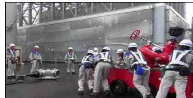
放水砲の設置
