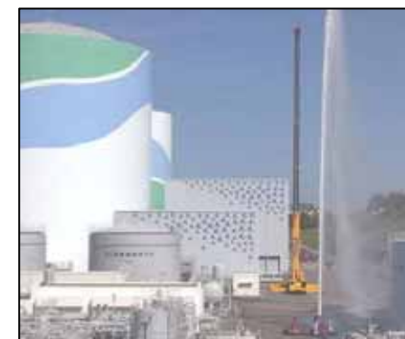
放水砲による放水
