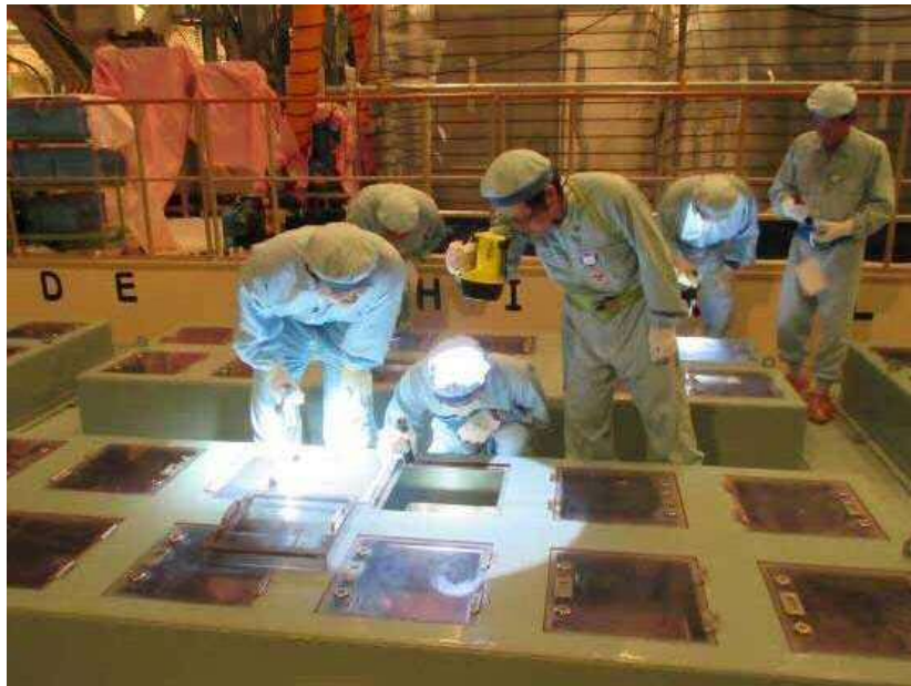
新燃料貯蔵庫ラック点検
