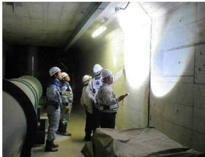
コンクリート構造物点検
