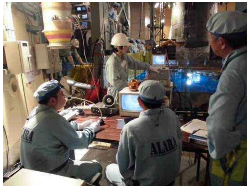
原子炉圧力容器内点検(撮影映像確認)
