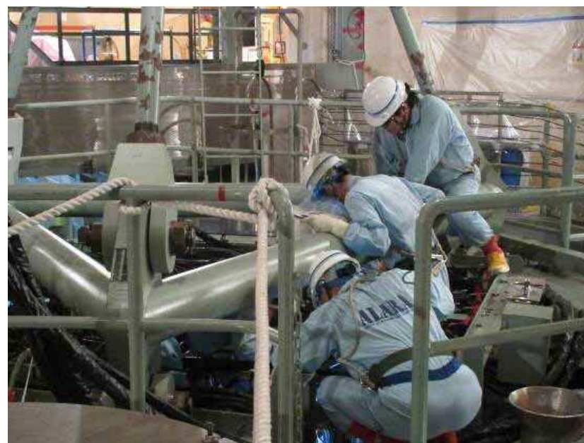
制御棒駆動装置、制御棒位置指示装置 ケーブルコネクタ部点検
