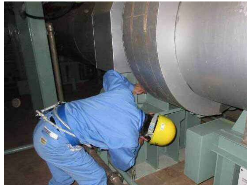
配管の支持装置点検
