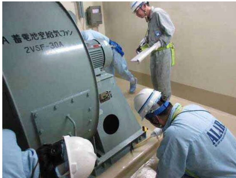
ファンの基礎ボルト点検
