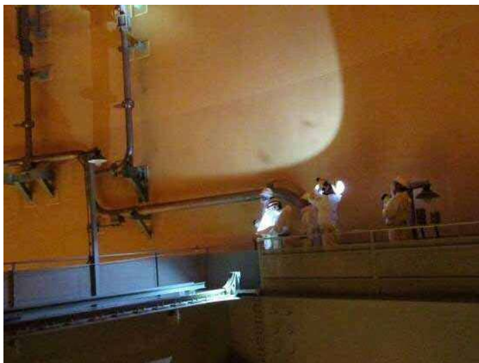
格納容器スプレイ配管点検
