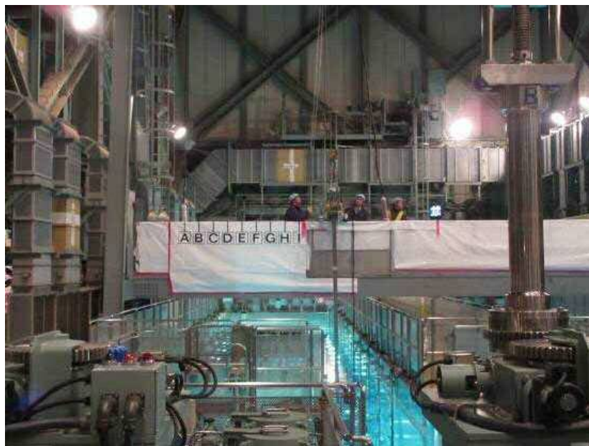
使用済燃料ピットラックセル点検(水中カメラ投入)
