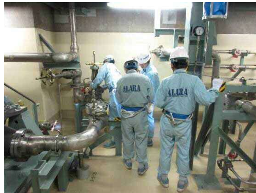
支持装置点検
