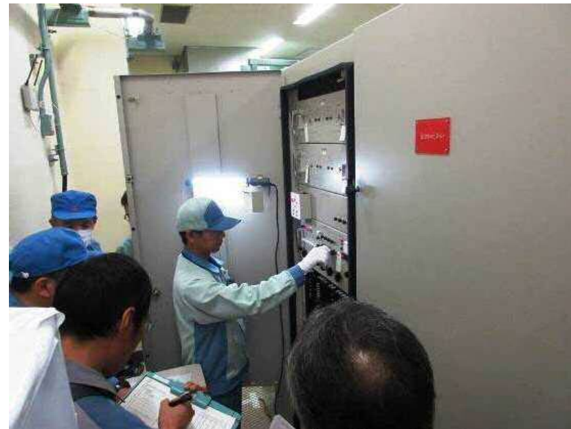
安全上重要な計装機器点検
