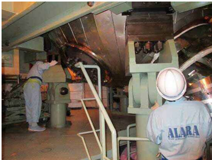
蒸気発生器支持構造物点検
