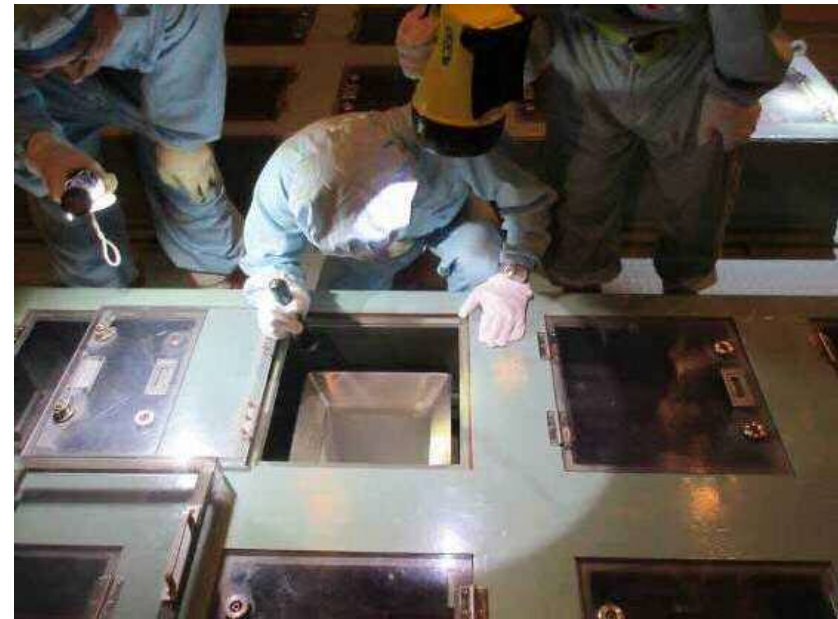
新燃料貯蔵庫ラック点検
