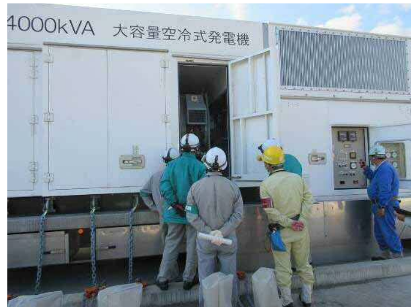
バックアップ設備点検(大容量空冷式発電機)
