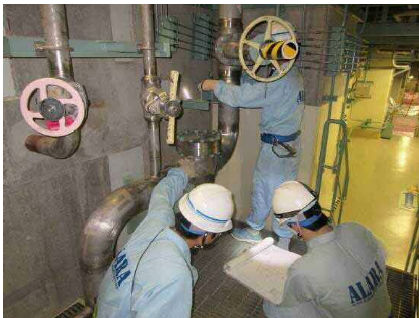
支持装置点検
