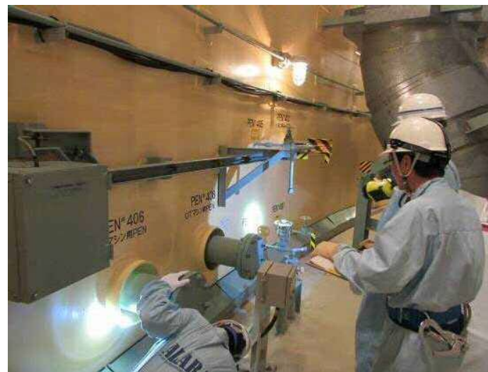
格納容器貫通部点検
