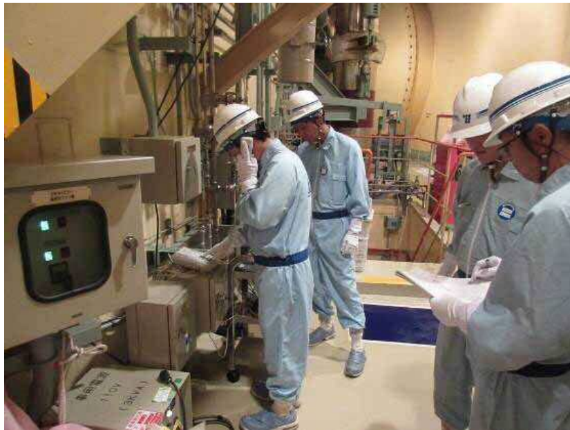
通信機器点検(所内放送・通話装置)
