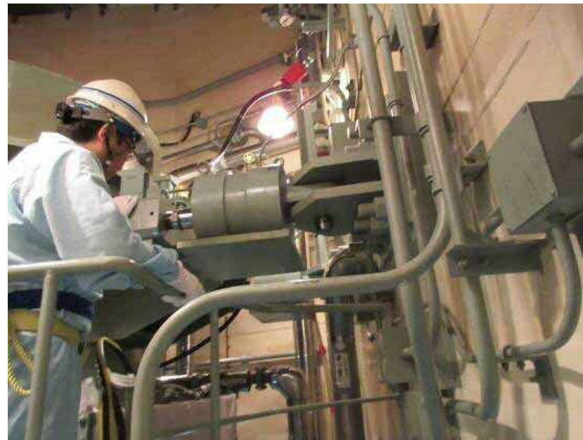
1次冷却材ポンプ支持構造物点検
