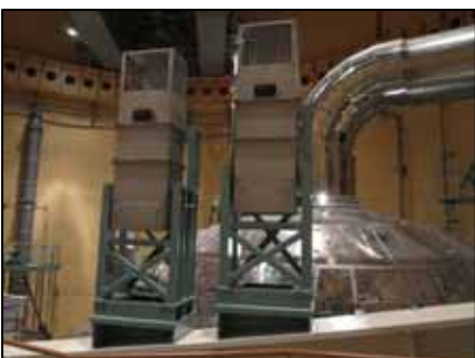
静的触媒式水素再結合装置
