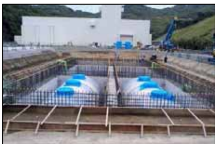
非常用ディーゼル発電機 燃料油貯蔵タンク増設
