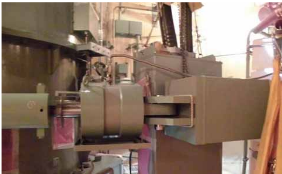
1次冷却材ポンプ支持構造物点検
