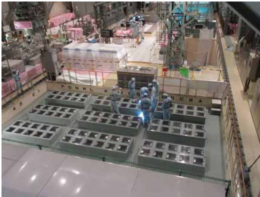
新燃料貯蔵庫ラック点検
