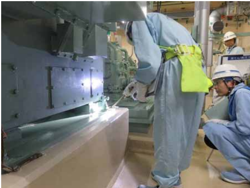
ポンプの基礎ボルト点検
