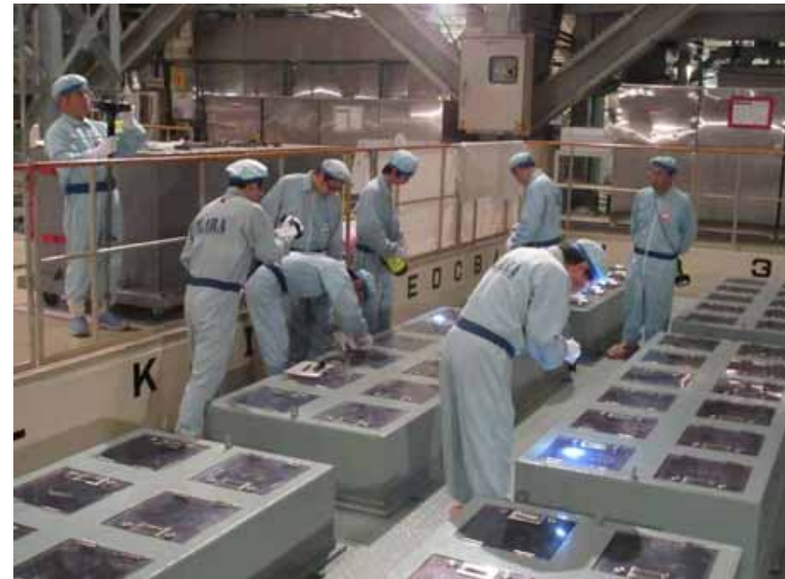
新燃料貯蔵庫ラック点検
