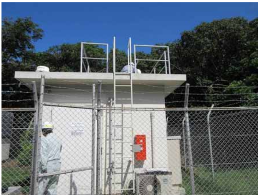
モニタリングステーション点検
