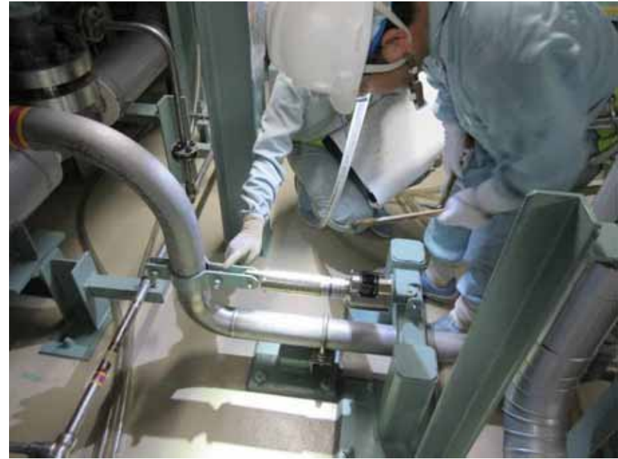
配管の支持装置点検
