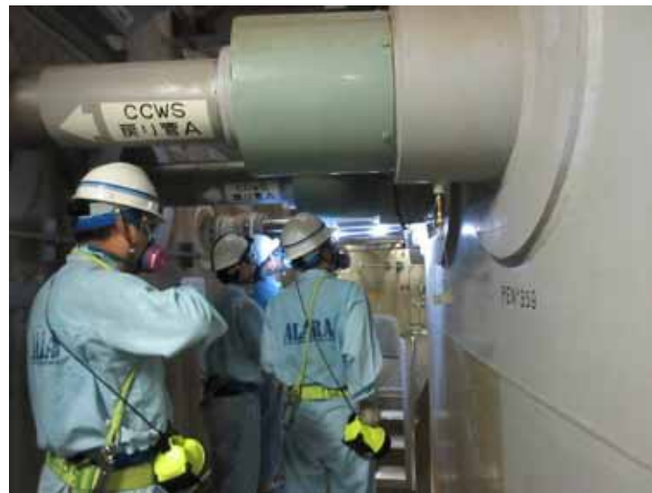
格納容器貫通部点検
