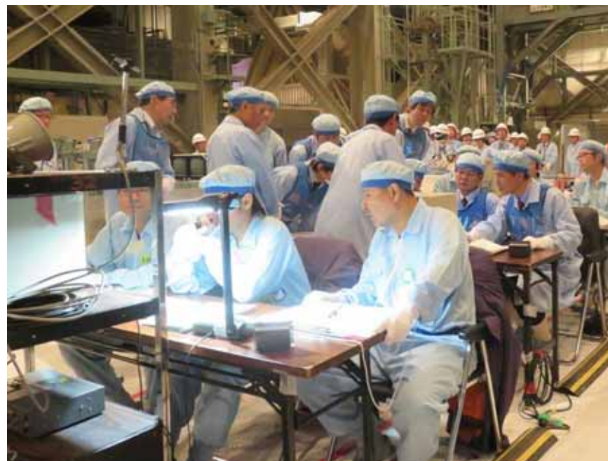
使用済燃料ピットラックセル点検(撮影映像確認)
