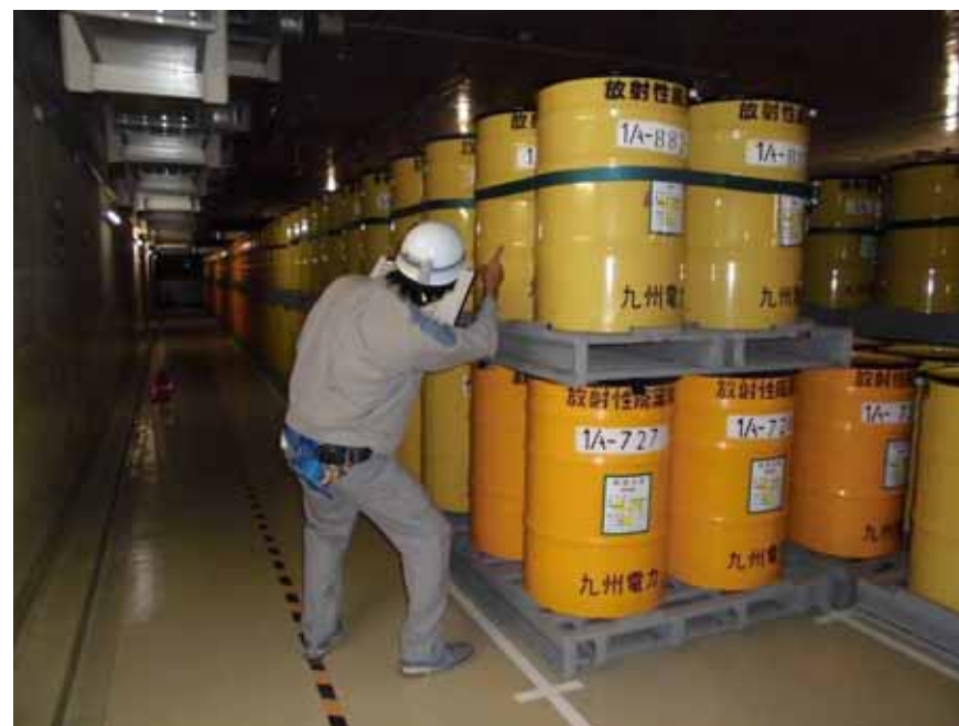
低レベル放射性廃棄物保管容器(ドラム缶)の 固縛状態点検
