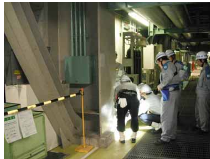
コンクリート構造物点検
