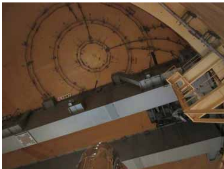
格納容器スプレイ配管点検
