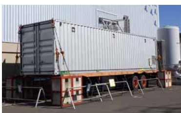
建屋外にある遠隔操作コンテナハウス
