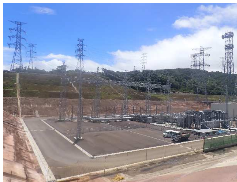
【特高開閉所 工事状況 (220kV工事完了)】
