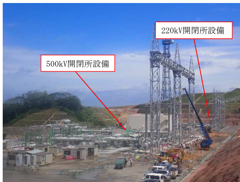
【特高開閉所 工事状況 (全景)】
