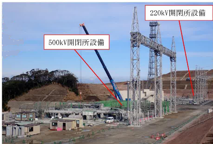
特高開閉所 工事状況 (全景)
