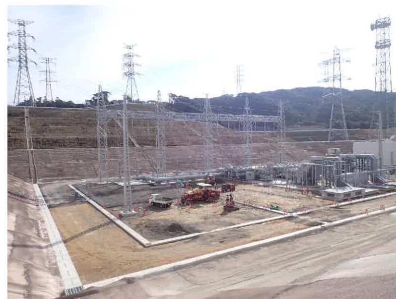
特高開閉所 工事状況 (220kV工事完了)
