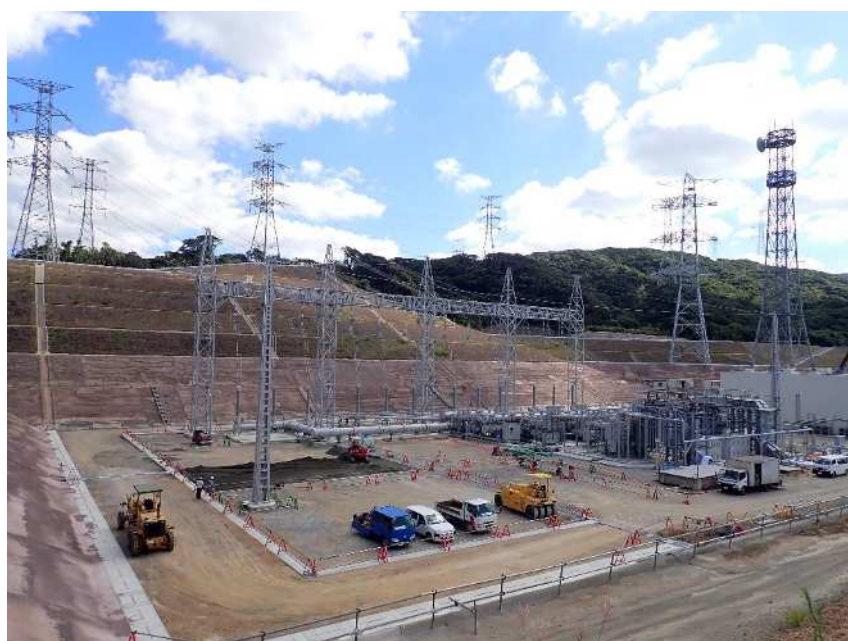
特高開閉所 工事状況 (220kV 工事状況)
