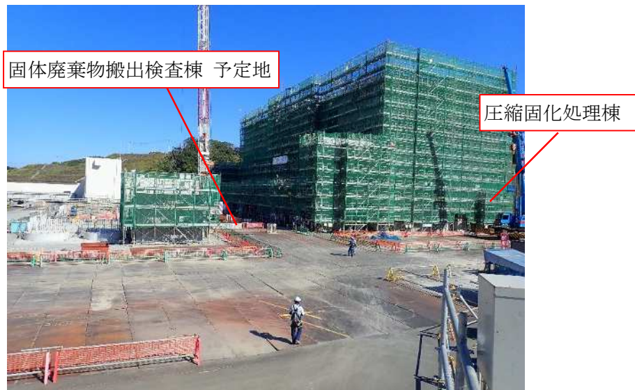
廃棄物搬出設備 工事状況 (建屋工事状況)
