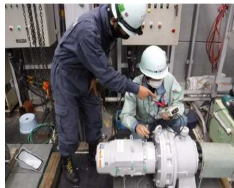
電動機点検作業の教育
