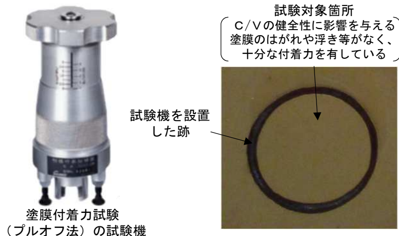
塗膜付着力試験後の様子（例） 3
