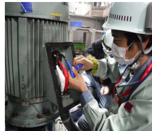
(電動機点検作業)
