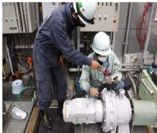
(電動機点検作業)
