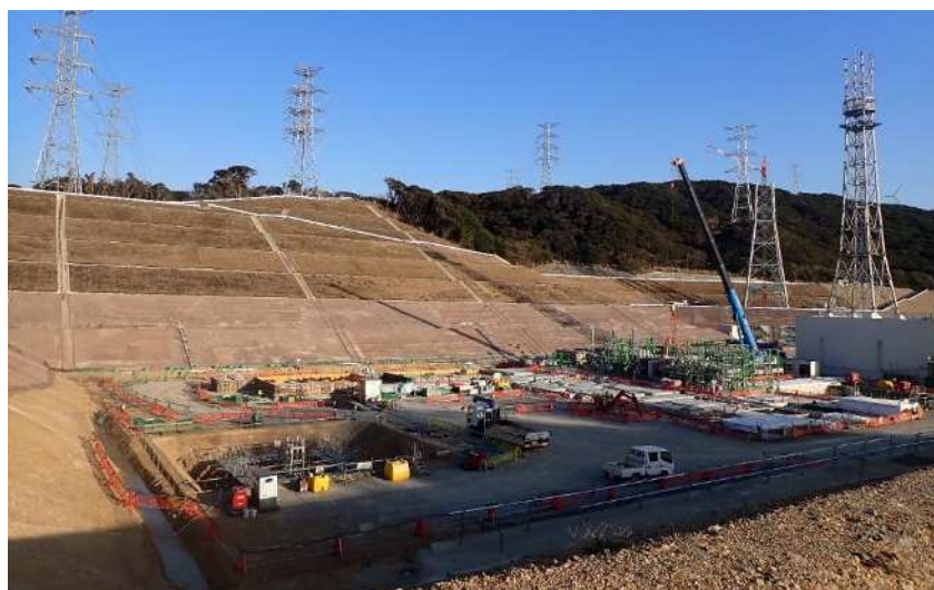
特高開閉所 工事状況 (220kV 工事状況)
