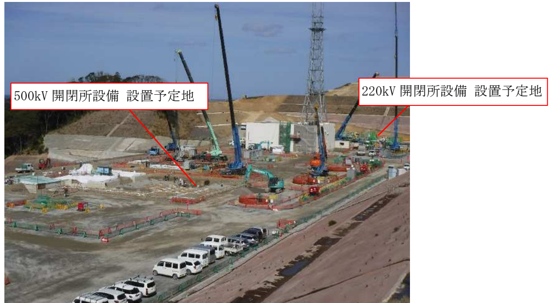
特高開閉所 工事状況 (全景)
