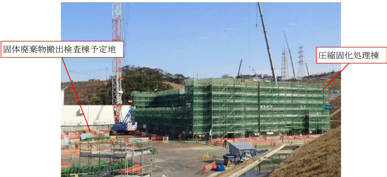
廃棄物搬出設備 工事状況 (建屋工事状況)
