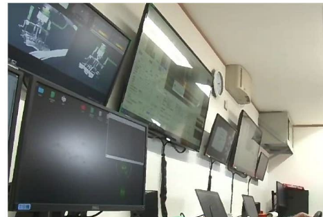
コンテナハウス内
