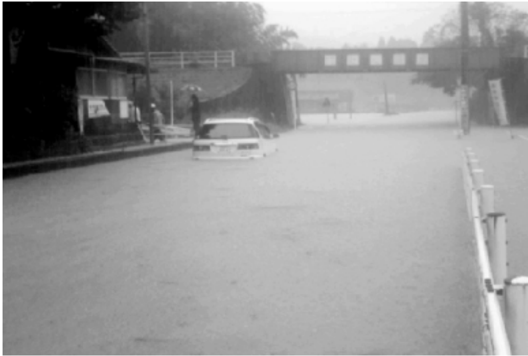
国道268号線【原口ガード付近】
