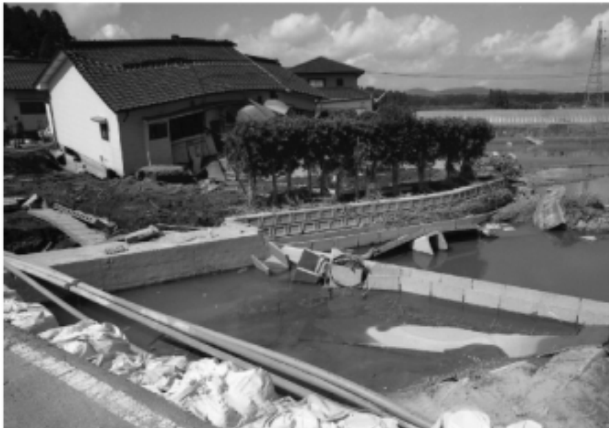
濁流により倒壊した住宅
