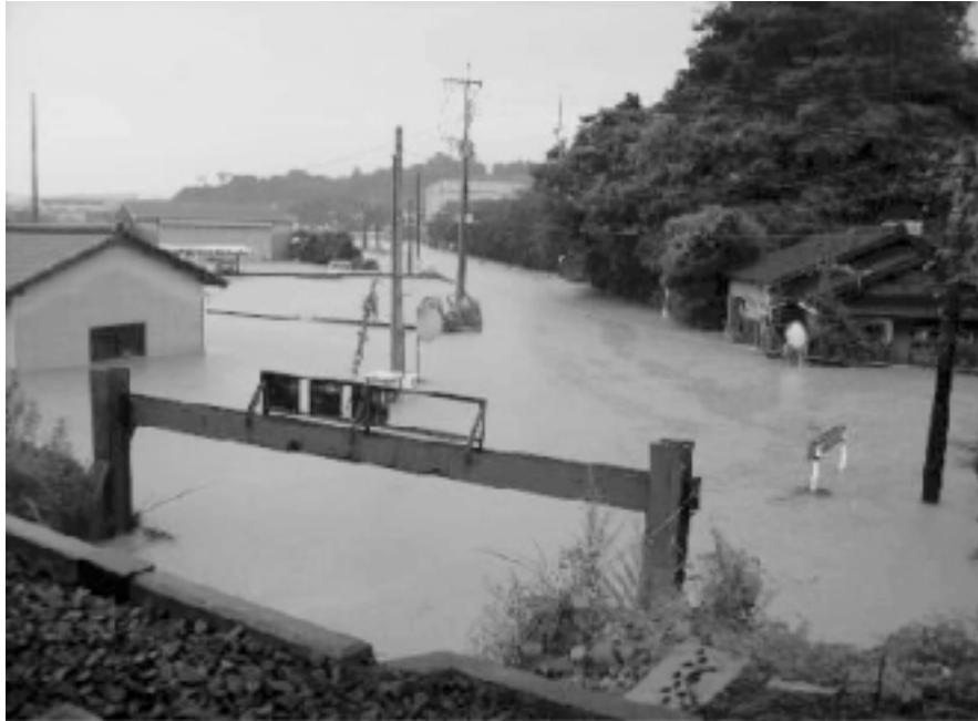
多くの浸水被害に見舞われた折多地区
