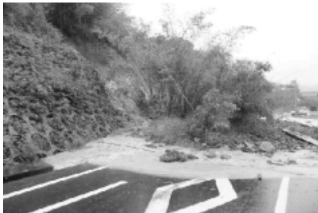
復旧工事に入った市道阿久根出水線（写真は災害発生直後）
