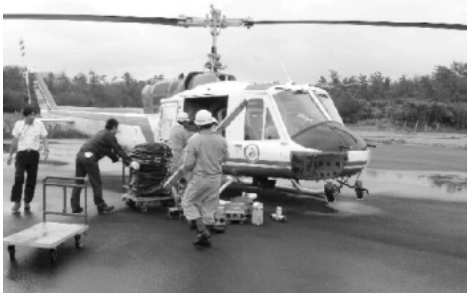
応急送電のための復旧資材積み込み状況
