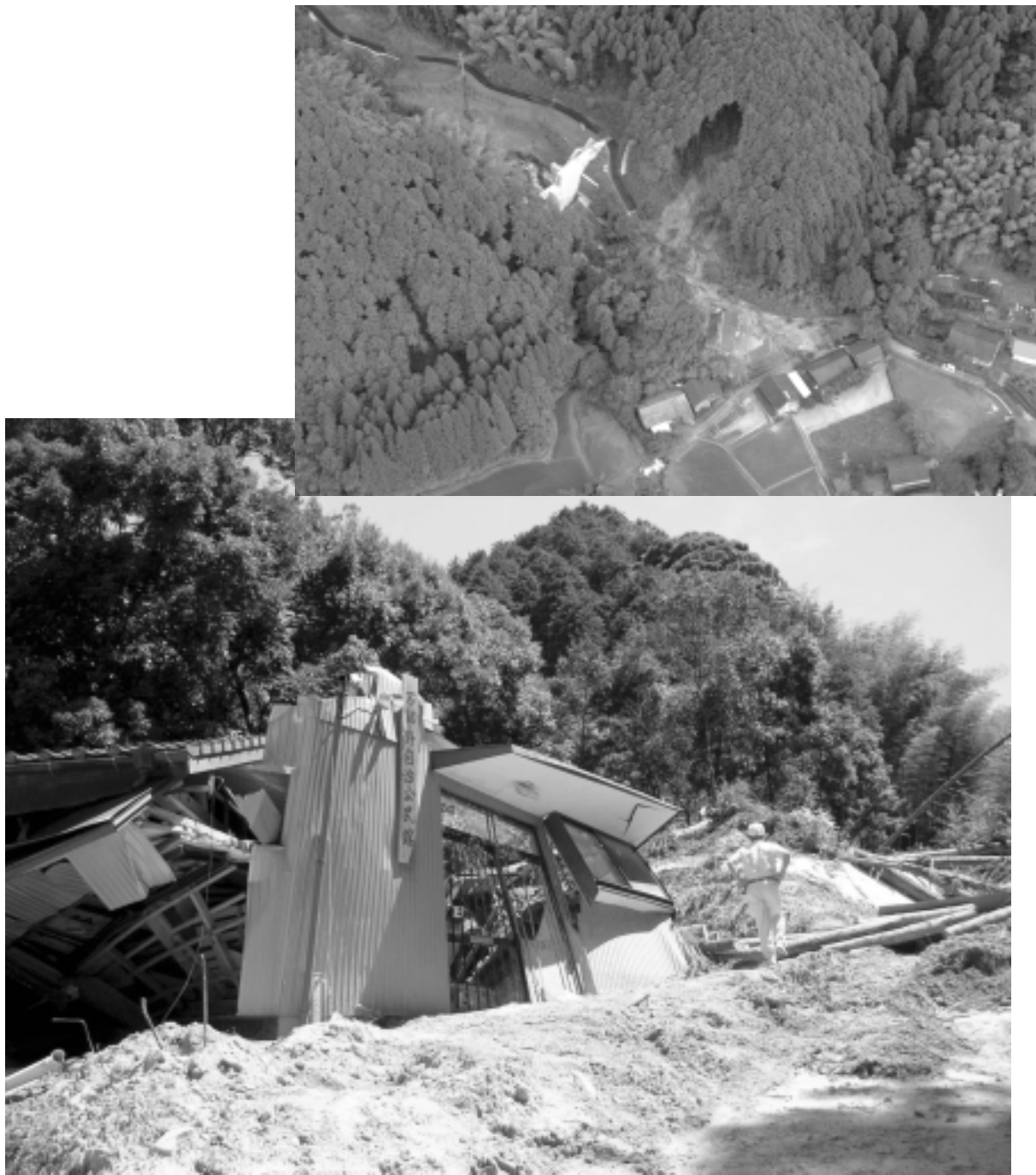
山腹崩壊により全壊した公民館（出水市不動野）
