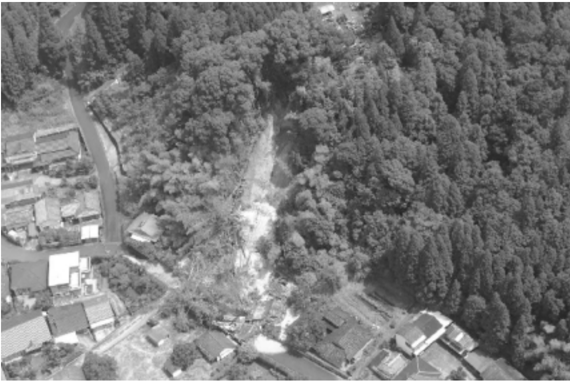
山腹の崩壊状況（大口市）
