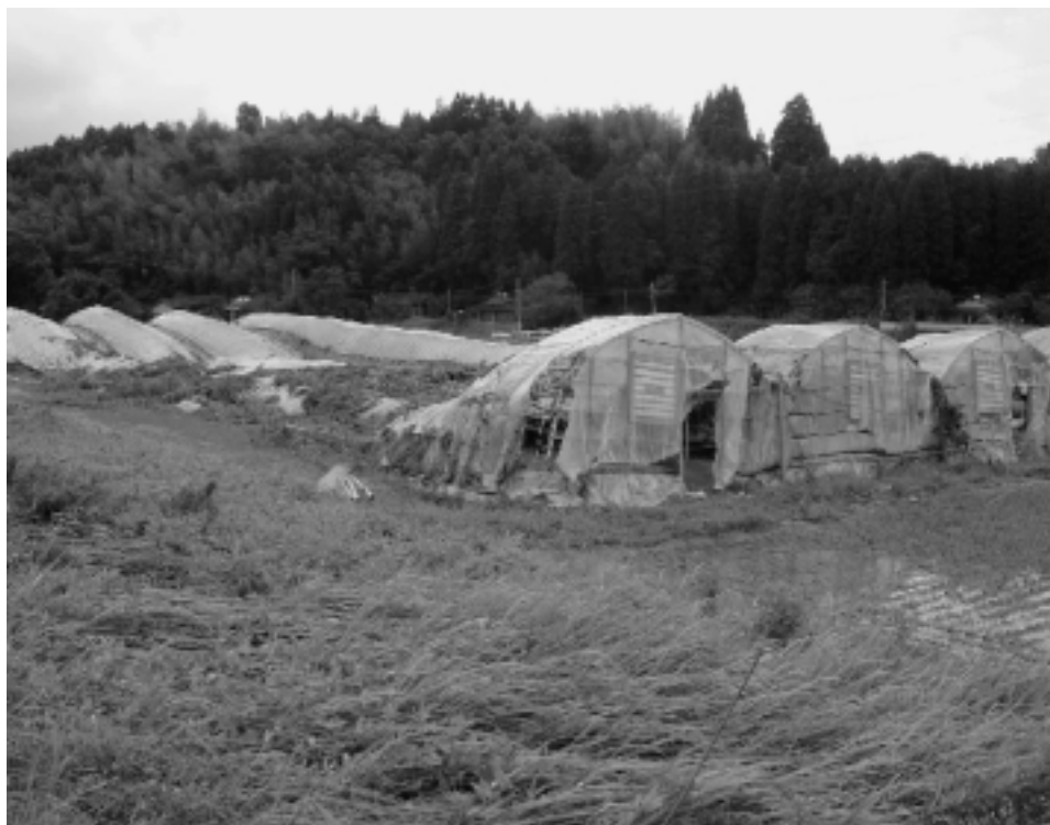
河川の氾濫により濁流に押し倒されたトマト・いちごのハウス（さつま町）
