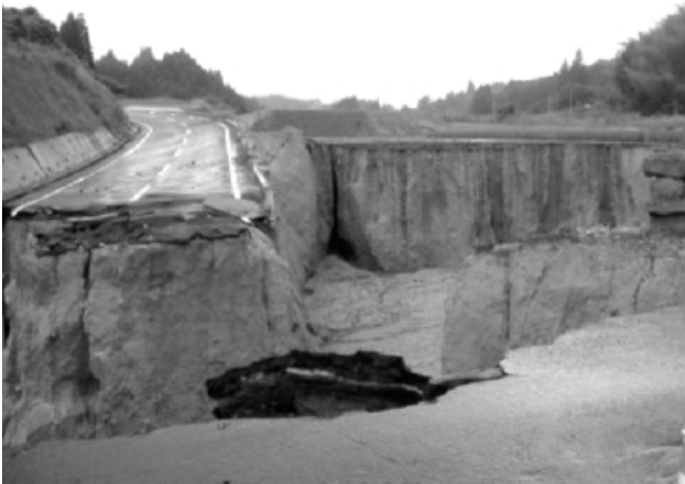
隣接する農地とともに流出し寸断された農道（さつま町）
