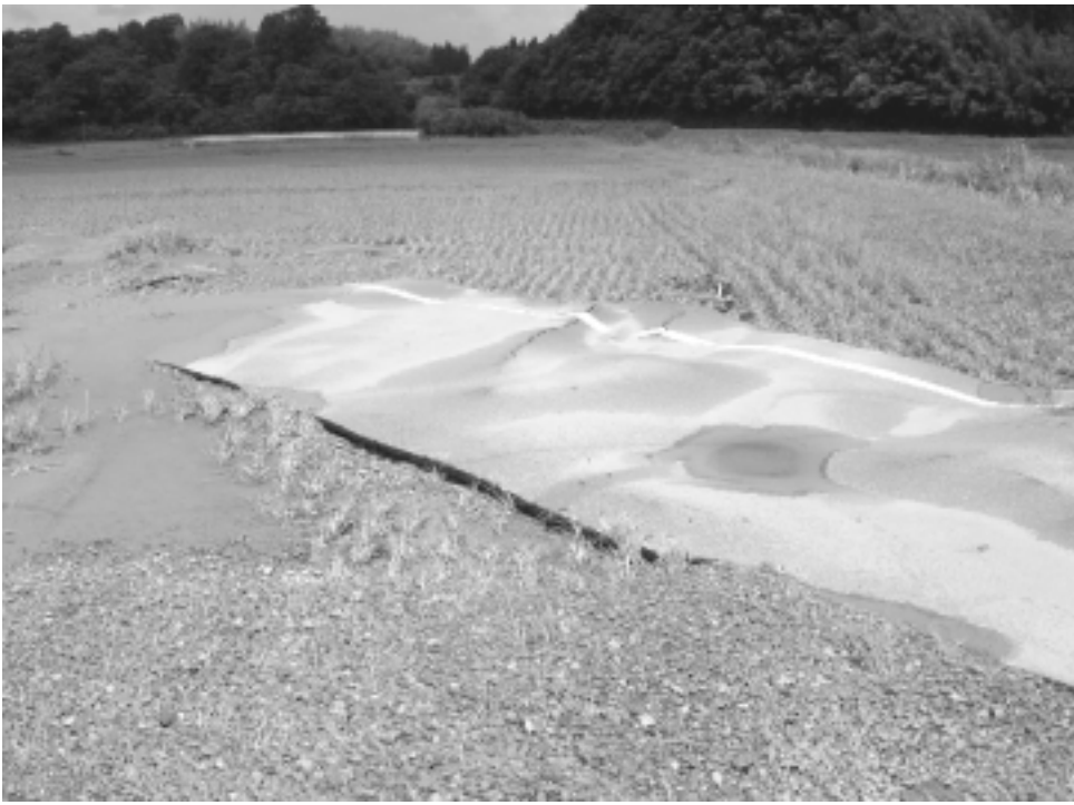
アスファルト表面が流出した道路（さつま町）
