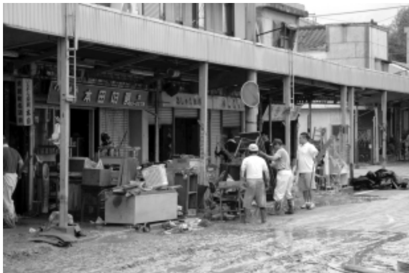
浸水により被災した店舗及び機械設備等（さつま町虎居地区商店街）
