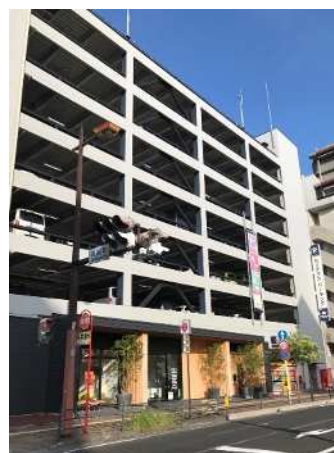
写真 6-14 1階部分を工夫した駐車場の例
