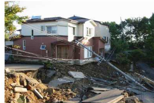
※新潟県中越地震の被害
