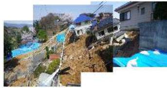
(d)液状化による側方流動の事例
