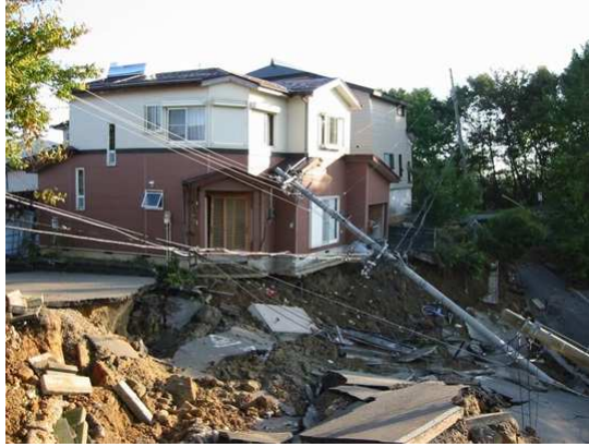
H16新潟県中越地震の被害
