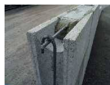
壁頂部の配筋のイメージ
